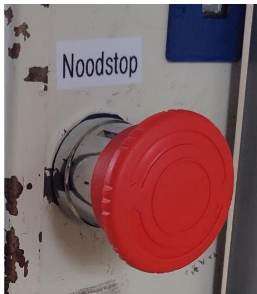
Figuur 35: Noodstopshakelaar op mijn schakelkast
