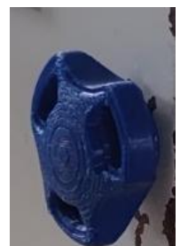
Figuur 61: (blauwe) Sluitschroef schakelkast
